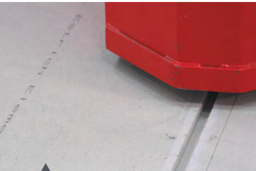
Met behulp van de gepatenteerde slijpmachine wordt een nauwkeurig sleuvenpatroon stofvrij en strak ingeslepen.
