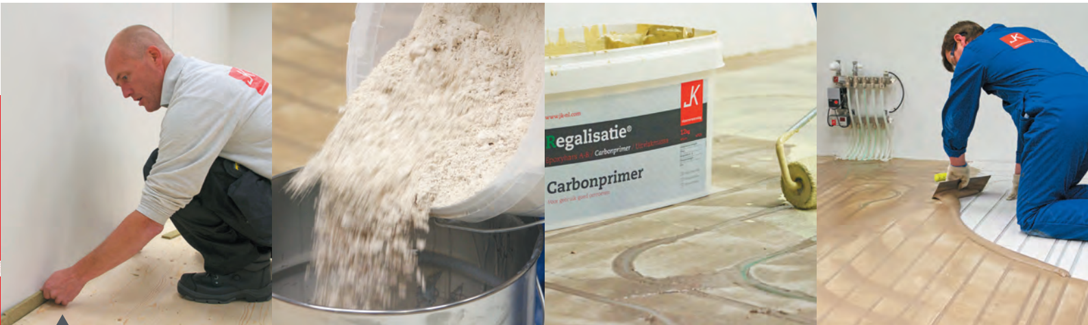
Het slijpsel dat bij het slijpen van de sleuven geproduceerd wordt kan in de JK Epoxyhars en de JK egalisatiemortel gerecycled worden, of worden hergebruikt in het productieproces bij Fermacell.
