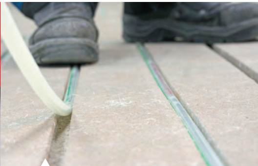
Het aanbrengen van de JK Flextube verwarmingsbuizen in de sleuven.
