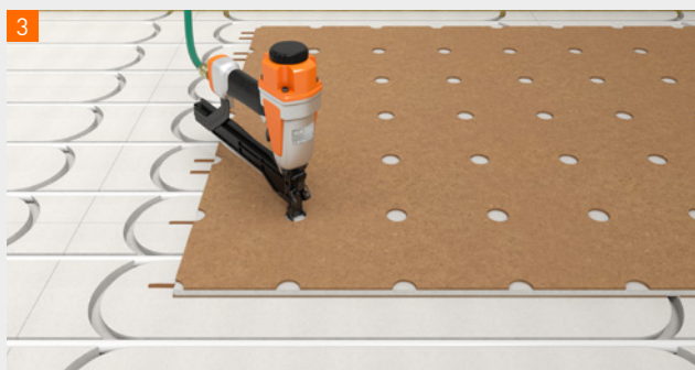
Placez la plaque supérieure et fixez-la mécaniquement au moyen de vis ou d'agrafes expansives en vous servant du gabarit.
