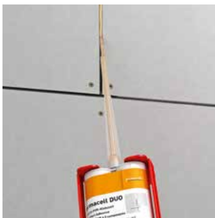
Colter après coup avec Colle à joint fermacell DUO - largeur de joint : 5 mm
