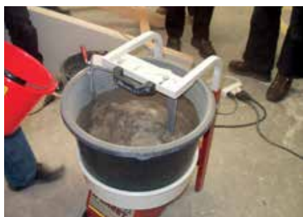
Préparer le Mortier expansif fermacell
