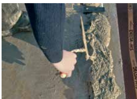
Appliquer le lit de mortier
