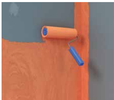
Illu. 6 : Appliquer au rouleau de la Sous-couche de protection à l'eau fermacell , en 2 couches, sur la totalité de la surface (épaisseur totale de l'enduit de couverture \geq 0,5 mm).
