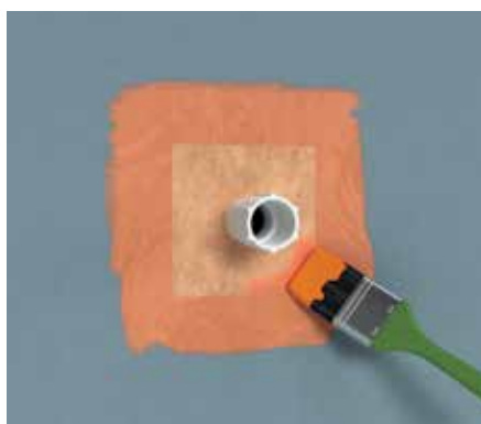
Illu. 4 : Sous-couche de protection à l'eau fermacell .
