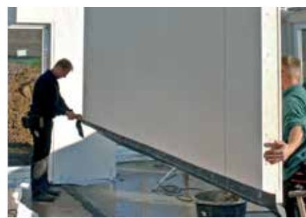
Poser la cloison dans le lit de mortier
