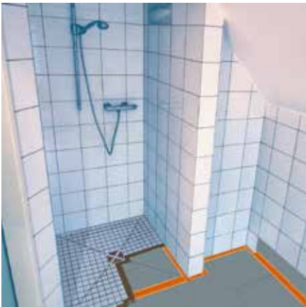
Illu. 4 : Les carrelages sont posés dans une mince couche de Mortier-colle flexible fermacell [ce qui garantit l'étanchéité pour la classe de contrainte hydrique A01]. Continuer à l'image 7.
