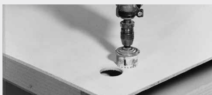
Découper à la scie cloche (pose d'un boîtier électrique)
