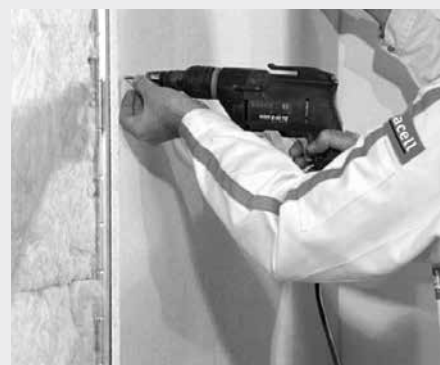
Fixation du parement par vis autoperceuses
