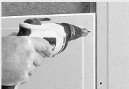
Vissage sur ossature métal
