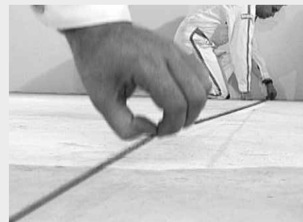
Traçage des axes de la paroi au cordeau ou au niveau laser
