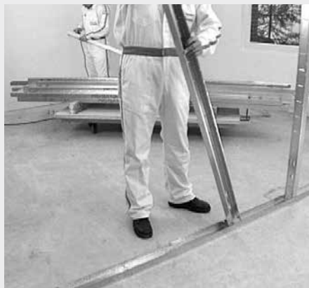
Montage des montants
