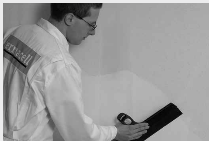
Surfacage à l'aide de l'Enduit de lissage fermacell ou de l'Enduit de surfacage fermacell
