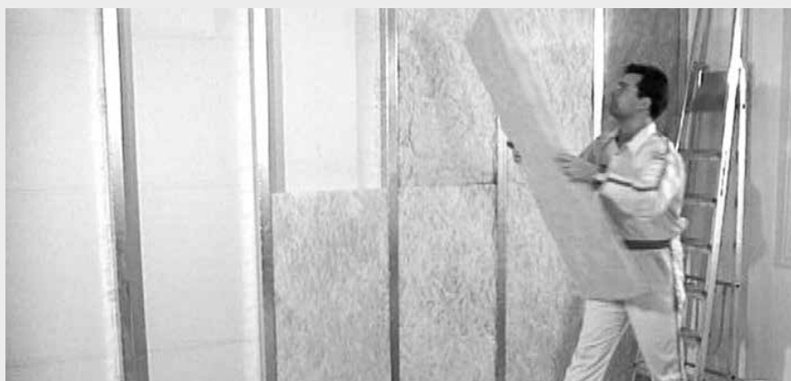
Pose de plaques isolantes
