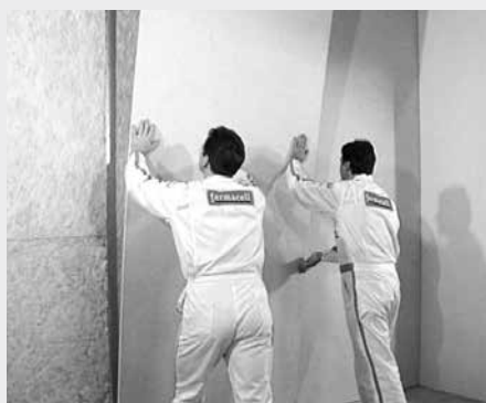
Pose d'un parement sur une ossature métallique
